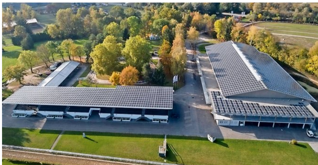
Die Fotovoltaikanlage auf den Dächern hat eine Grösse von 4000 Quadratmetern.
